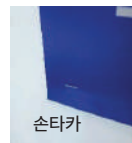
수성 페인트 마감인 5.5mm 합판으로 되어있어 압정 시공용이
